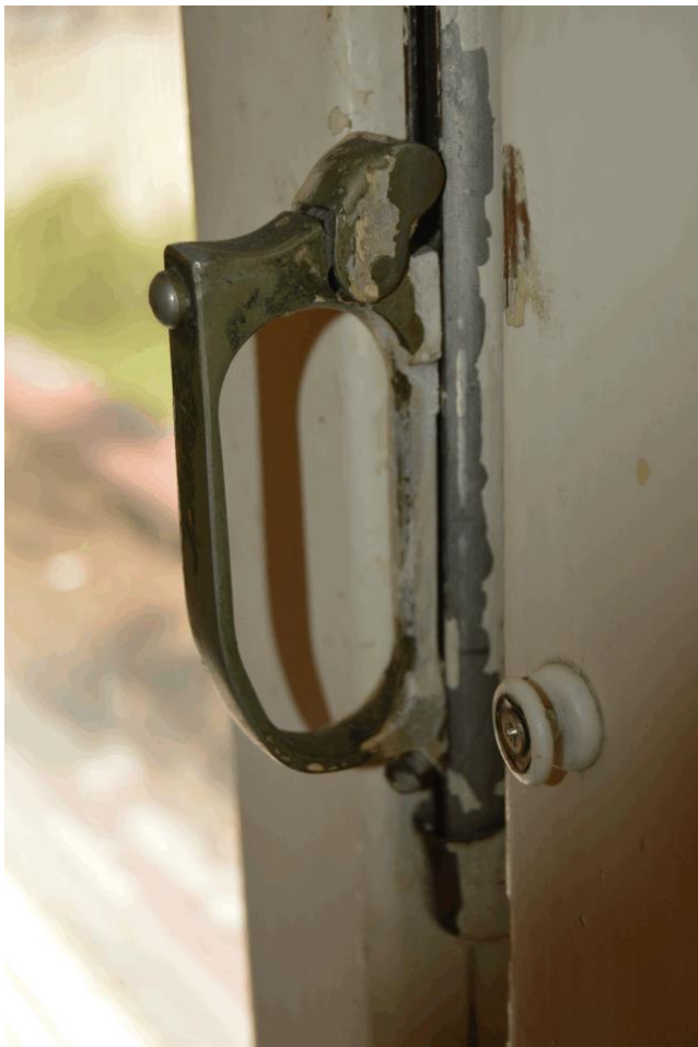
detail madla ovládání sklápěcího okna
