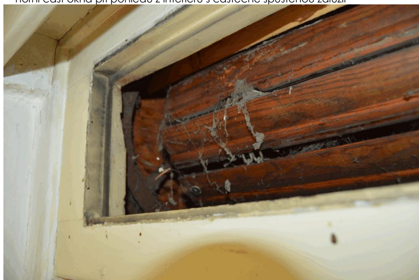
otevřená skříň v nadpraží okna s navinutou žaluzií a s kolem pro otáčení hřídele
