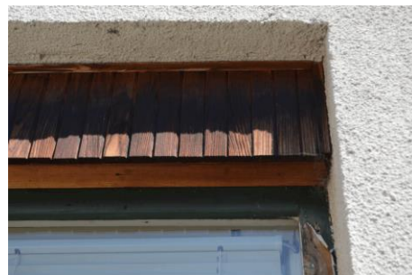
Vykrytí prostoru nad oknem bedněním na vnější straně
