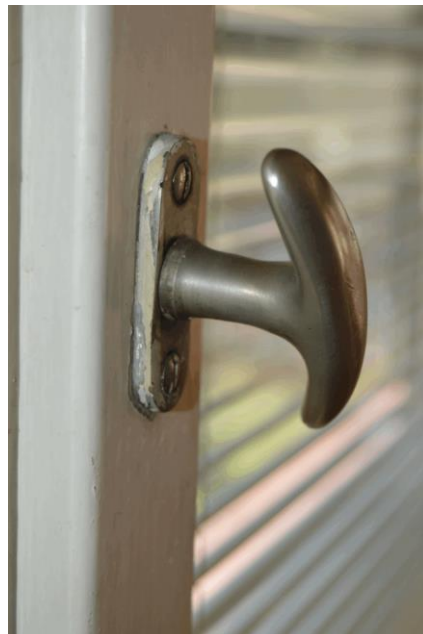
detail olivy zavírání dvoukřídlé části okna
