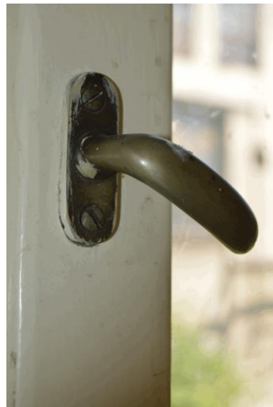
detail půlolivy zavírání křídla
