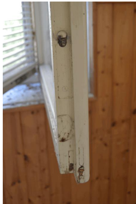
pohled rozevřené okenní křídlo, vnitřní část se západkou zavírání
