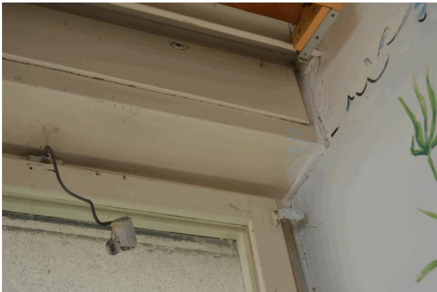
horní část okna se skříňí kryjící vnější žaluzii
