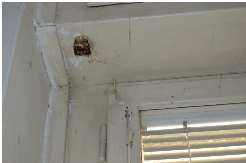
detail skříně pro žaluzii s kladkou ovládacího popruhu
