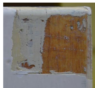
detail sondy do nátěru víka skříně pro žaluzii s odkrytým povrchem dřeva
