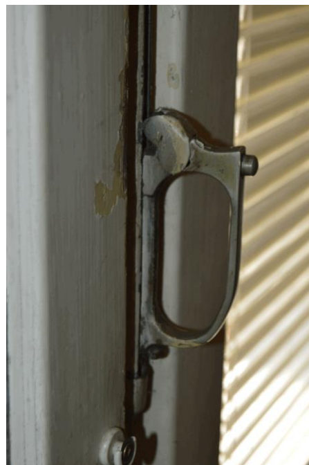
detail madla pro ovládání sklápěcího dílu
