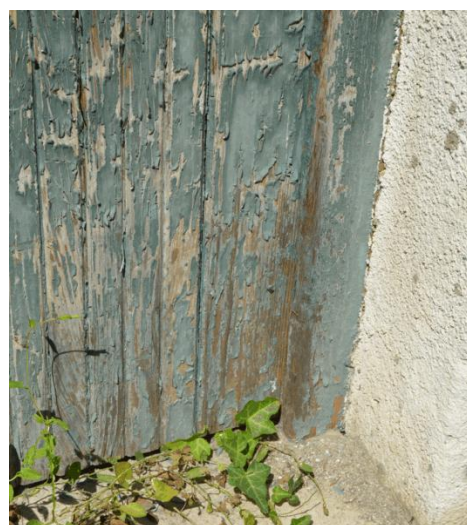
latové bednění spodní části dveřního křídla
