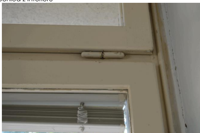
pravá horní část okna se závěsem vyláppěcího křídla
