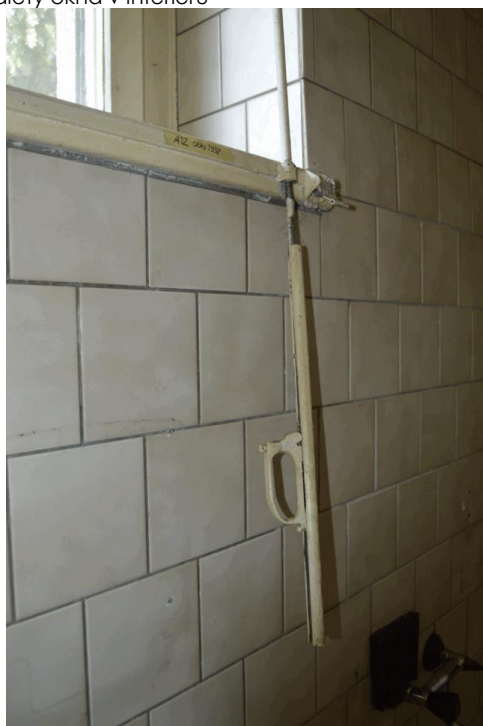
táhlo pro ovládání sklápěcího dílu okna
