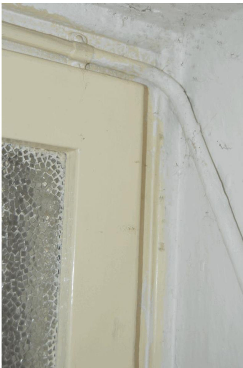
detail horní části okna s vedením táhla zavírání
