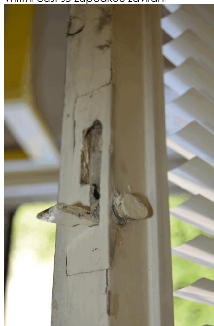
detail pákového uzávěru pro spřažení okenních křídel
