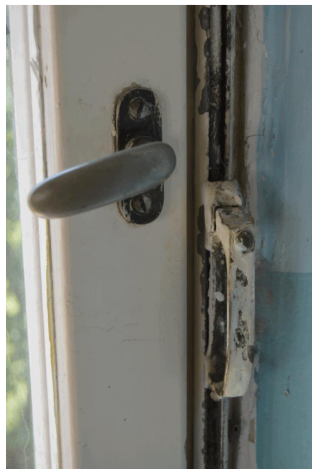
detail půlolivy zavírání křídla a madla k ovládání horního sklápěcího dílu okna
