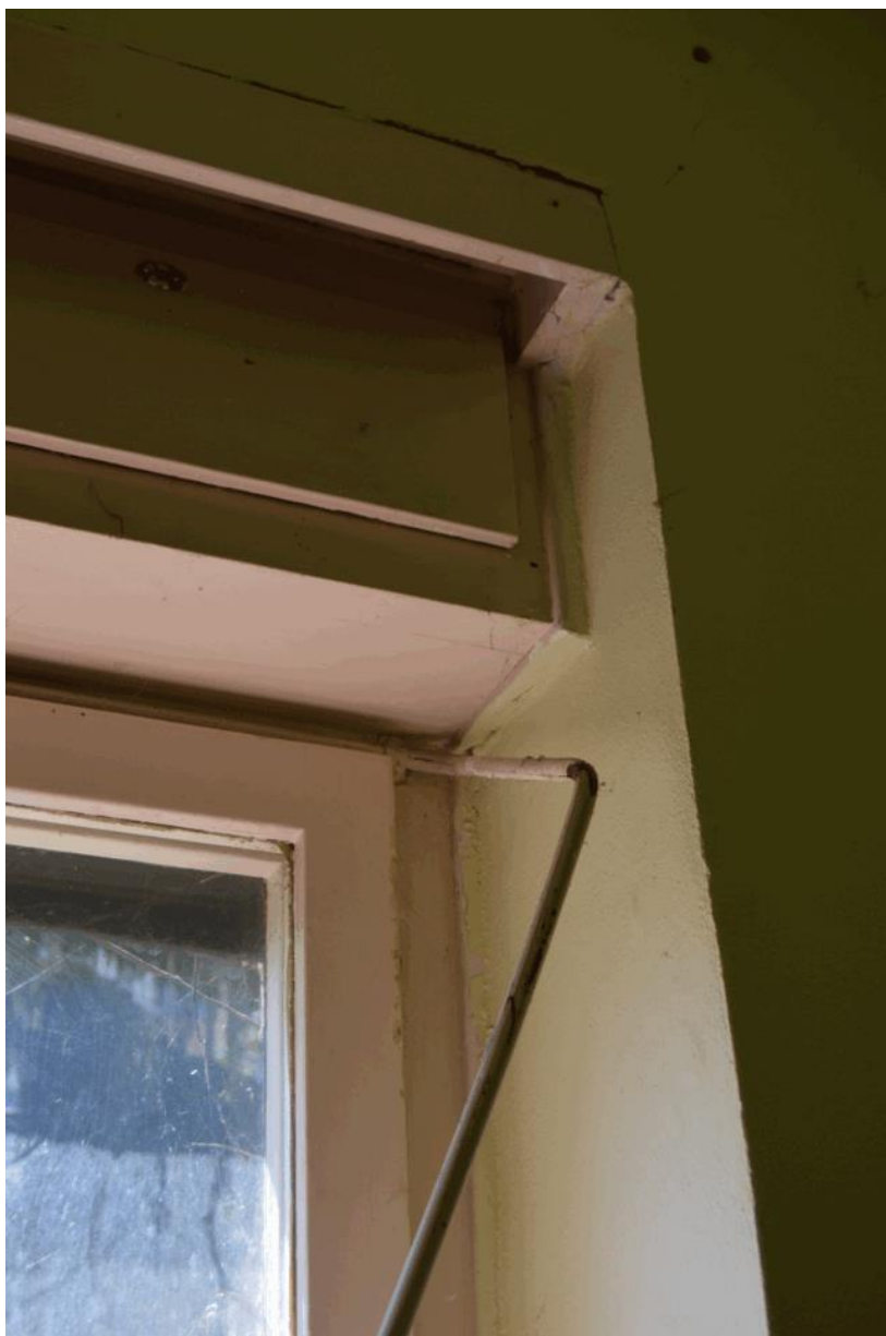
horní část okna se skříňí žaluzie a stáhlem ovládání sklápěcího dílu
