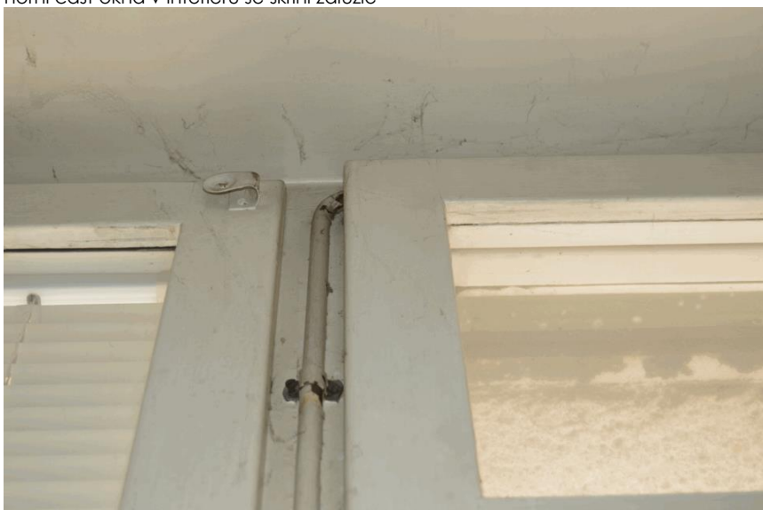
horní část okna s táhlem ovládání sklopného dílu
