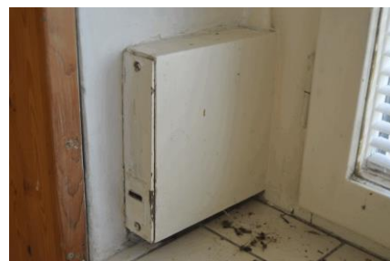
plechová krabice kryjící mechanismus navíjení popruhu žaluzie
