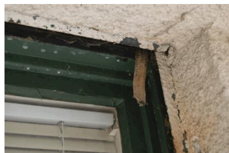
horní část okna z vnější strany, vytržený popruh ovládání rolety
