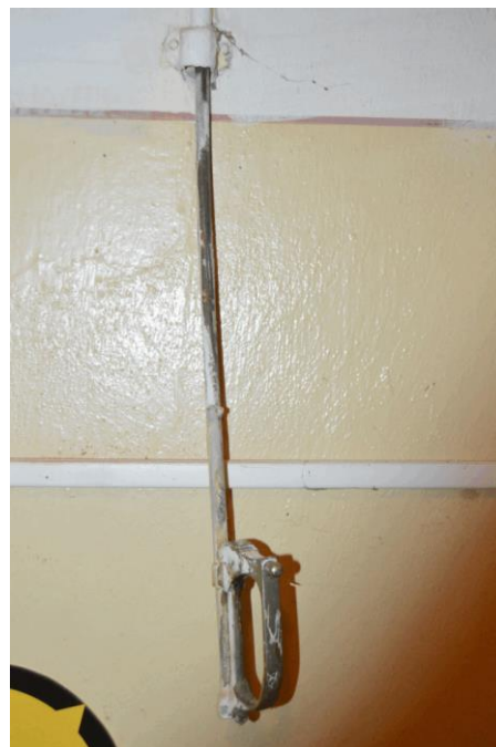
detail madla s táhlem pro ovládání sklápěcího dílu
