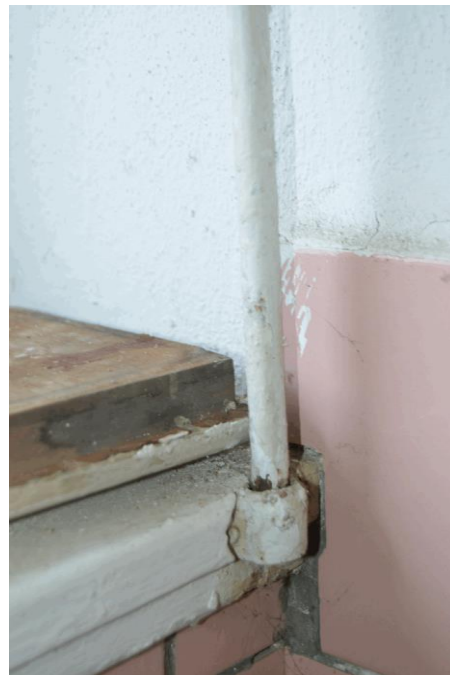
detail vedení táhla pro sklápění okna
