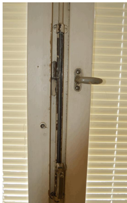
detail olivy a táhla ovládání sklápěcího dílu
