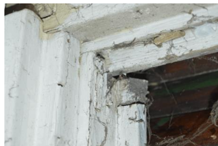
detail dodatečně vloženého sloupku
