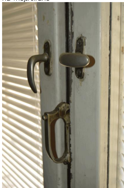
olivy zavírání oken a páka mechanismu sklápění horního dílu
