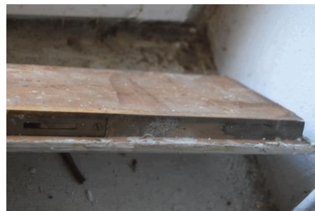
otevřené čelo skříně pro žaluzii
