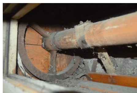
hřídel navíjení žaluzie s hnacím kolem
