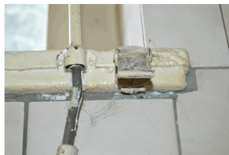
vedení táhla na parapetu okna
