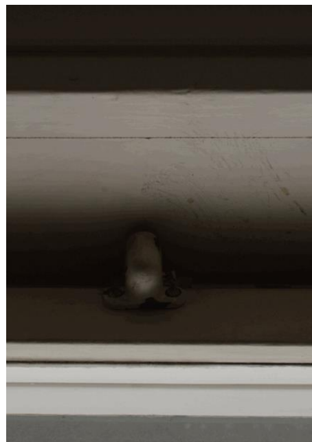
detail skříně pro žaluzii a krytu vyvedení lanka pro ovládání sklápěcího dílu
