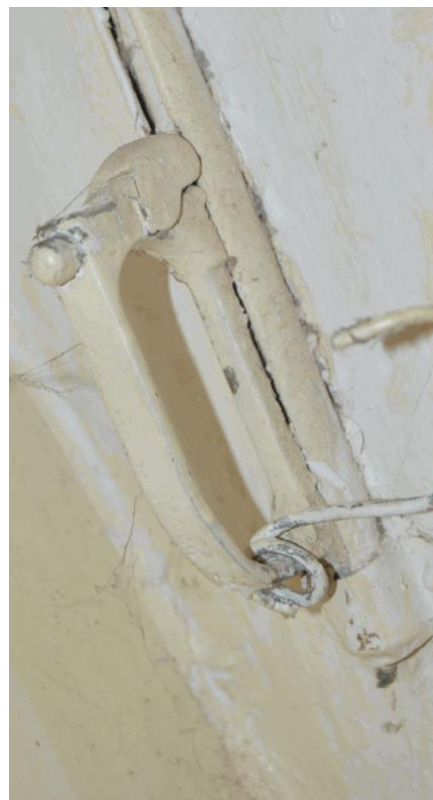
detail madla zavírání okna
