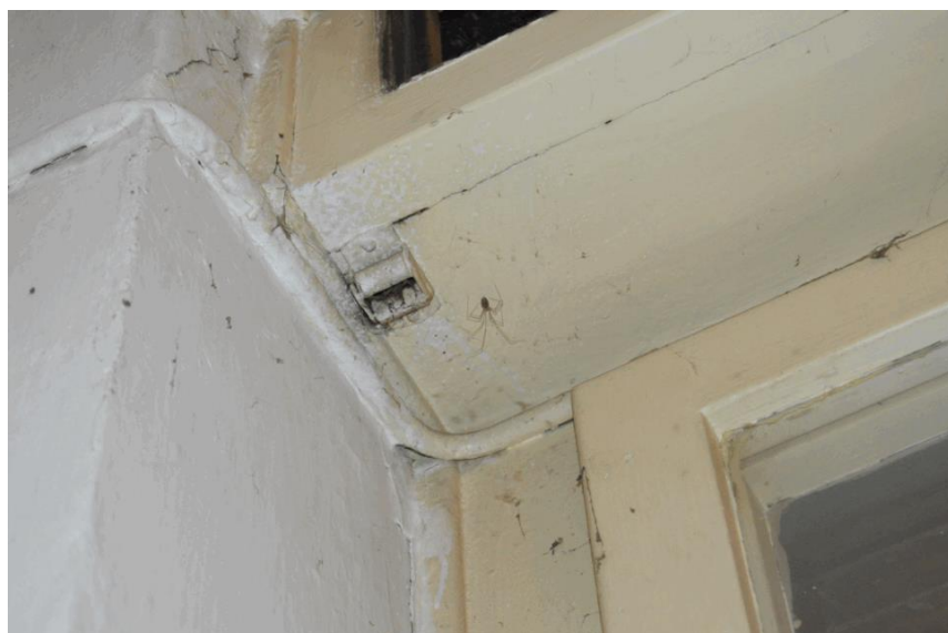
detail sodní strany skříňně pro žaluzii svedením popruhu vytahování
