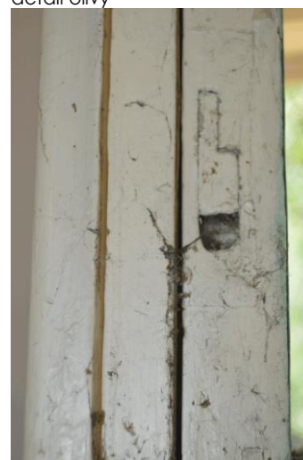
detail spřažení okenních křídel s páčkou zavíracího mechanismu
