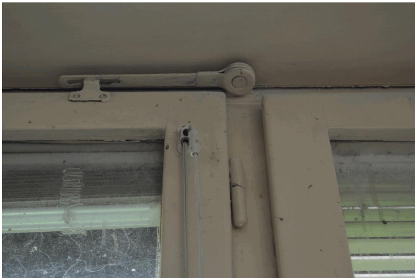
horní část středního křídla se ztužujícím ramenem pro otevření
