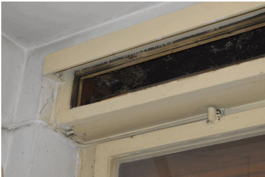
horní část okna s otevřenou skříňí žaluzie
