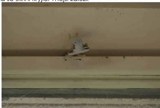
detail krytky se západkou zavírání sklopného křídla
