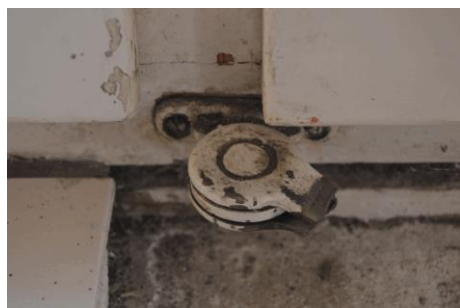
detail kloubu nadlehčujícího ramena
