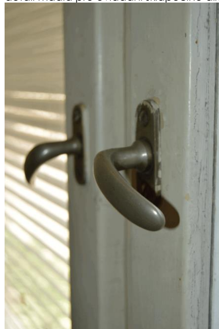
půlolyvy zavírání okenních křídel
